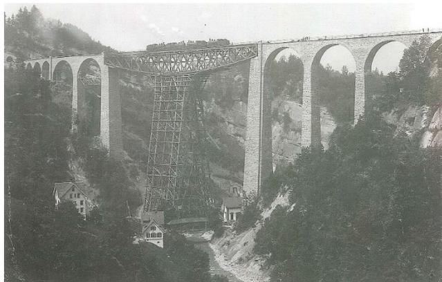
*Belastungsprobe mit 4 Dampfloks 1910*
