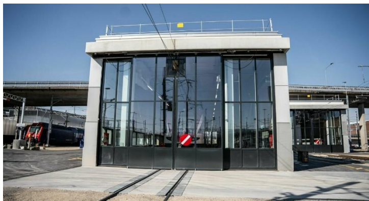
Die neue «Boxengasse» für die Züge der SBB in Zürich: Das Radatzbearbeitungszentrum im Vorbahnhof HB Zürich
