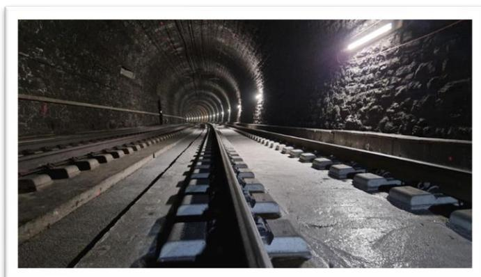
L'été dernier, lors de passages de contrôle dans le tunnel de faîte du Lötschberg, BLS a constaté des dommages sur la voie ferrée en béton. Des examens approfondis ont montré que les dommages se concentraient à deux endroits du tunnel long de 15 kilomètres: d'une part, à environ 3,5 kilomètres du portail nord du tunnel près de Kandersteg, d'autre part, à environ 4 kilomètres du portail sud près de Goppenstein. Les dommages constatés sur la voie ferrée en béton sont dus à des
