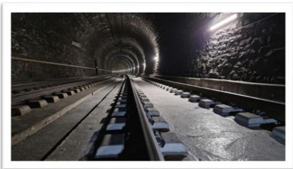
Im letzten Sommer hat die BLS während Kontrollgängen im Lötschberg-Scheiteltunnel Schäden an der Betonfahrbahn festgestellt. Nach genaueren Untersuchungen hat sich gezeigt, dass die Schäden im 15 Kilometer langen Tunnel an zwei Stellen auftreten: einerseits rund 3,5 Kilometer vom nördlichen Tunnelportal bei Kandersteg, andererseits rund 4 Kilometer vom südlichen Portal bei Goppenstein entfernt. Die Schäden an der Beton-
