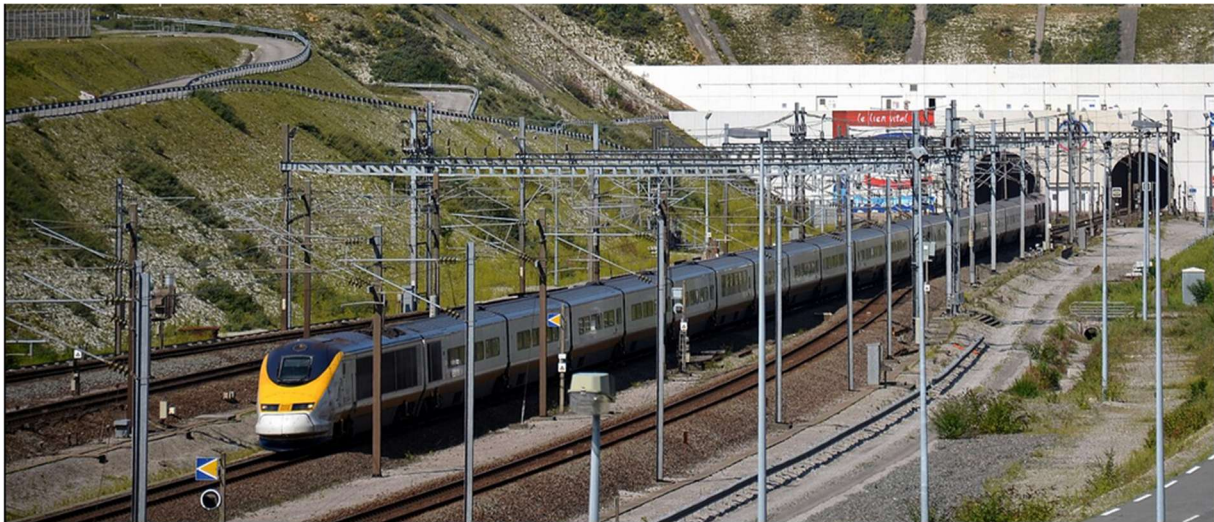
Ein Eurostar e300 verlässt den Kanaltunnel Richtung Süden (Quelle: Wikimedia Commons, Billy69150)
